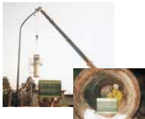
解体した焼却施設(沼津工場)
