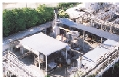
廃止した焼却設備(明石工場)
