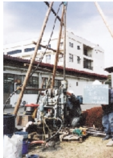
ボーリング調査
