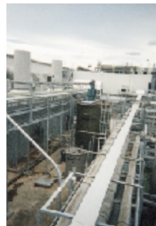
塩化銅再資源化設備 (富士通コンピュータ・プロダクツ・オブ・ベトナム)
