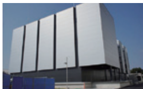
新棟(免震データセンター)
