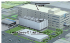
明石システムセンター外観
