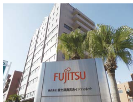
富士通データセンター(株式会社富士通鹿児島インフォネット)
