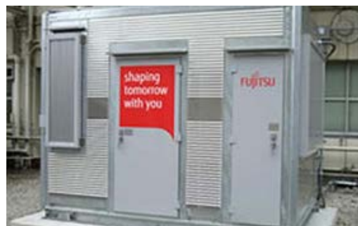
試作コンテナデータセンター
