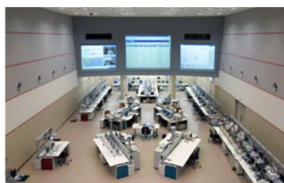
館林システムセンター統合管制室
