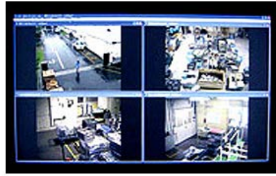
監視カメラシステム
