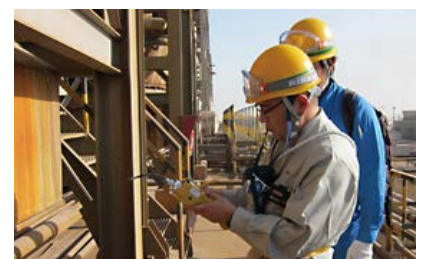
ダンマン第二工業団地での現地調査の様子
