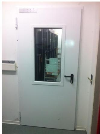
**Bild 3: Brandschutz gesicherten Zugang zum IT Room durch den Technikraum**
