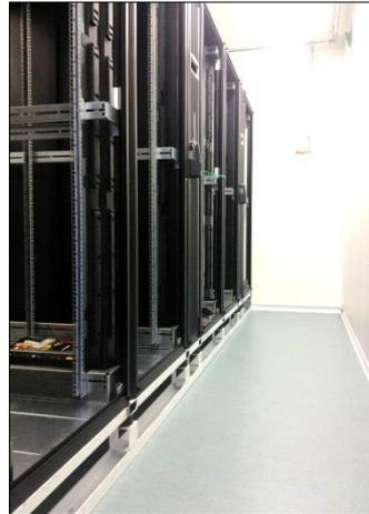
**Bild 1: Optionalen Rack Träger System für RZ Umzüge ohne Ausbau der IT Systeme**
