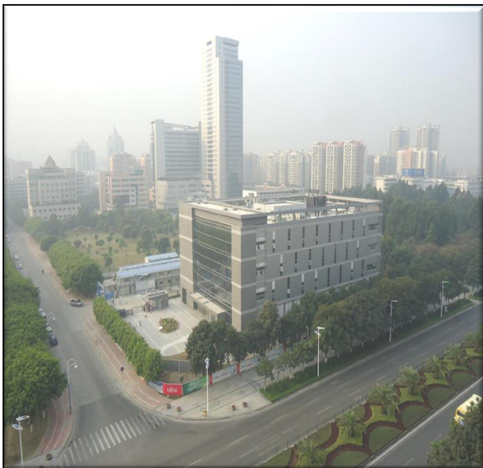
数据中心专用建筑
