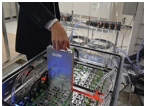
サーバをフロリナートの中に浸して冷却する液浸冷却技術
