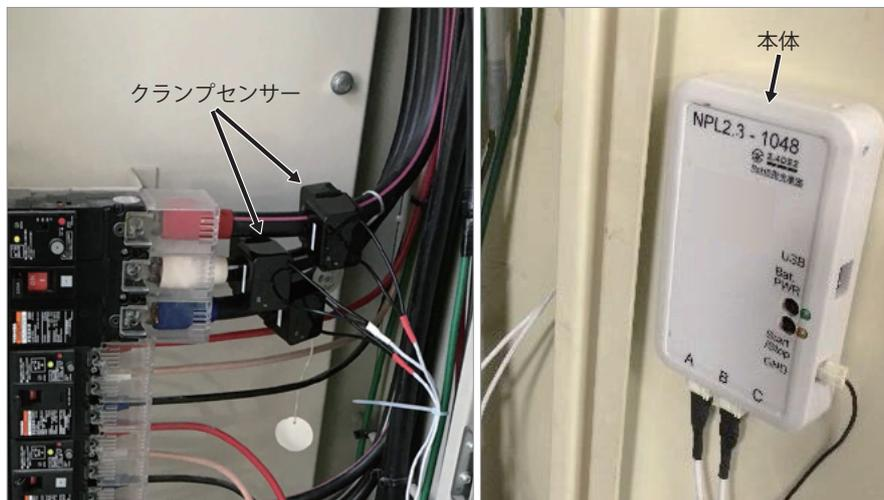
図-3 分電盤へのNPL設置例
