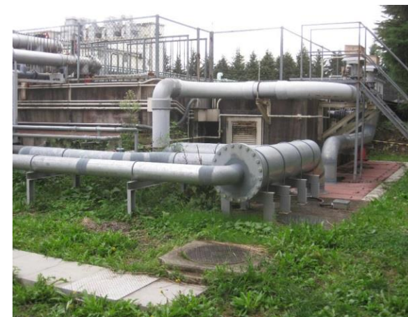
<埋設配管 架空化後>
