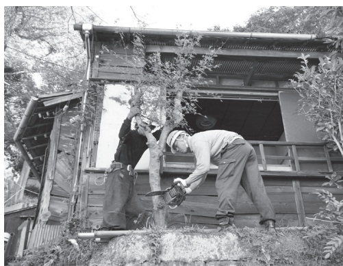
空き家対策特措法に基づいて取り壊される木造住宅＝神奈川県横須賀市
