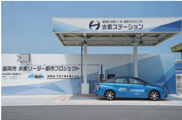
●写真 福岡市中部水処理センターに設置された水素ステーション
